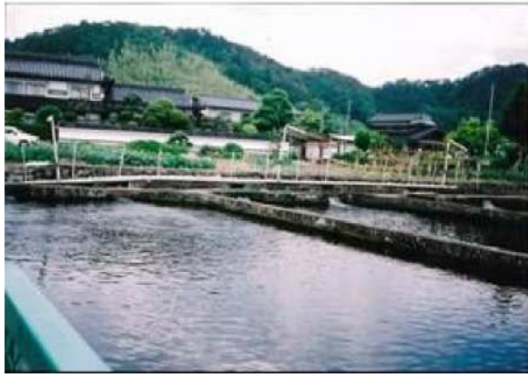
写真5. 工事前のニジマス池
