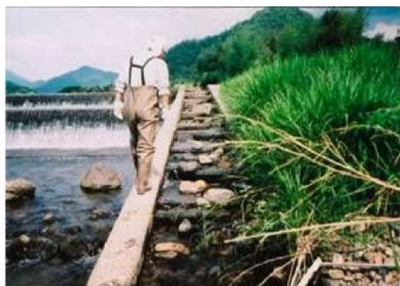
写真4. 中川堰の魚道
