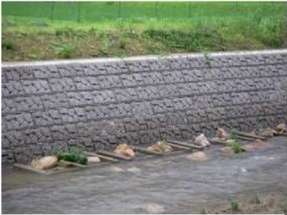
写真12. 護岸裾のコンクリート沈床工
