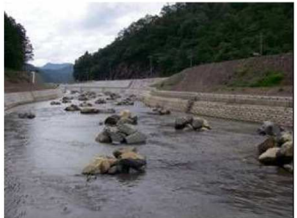
写真11. 大石を河川内に再配置
