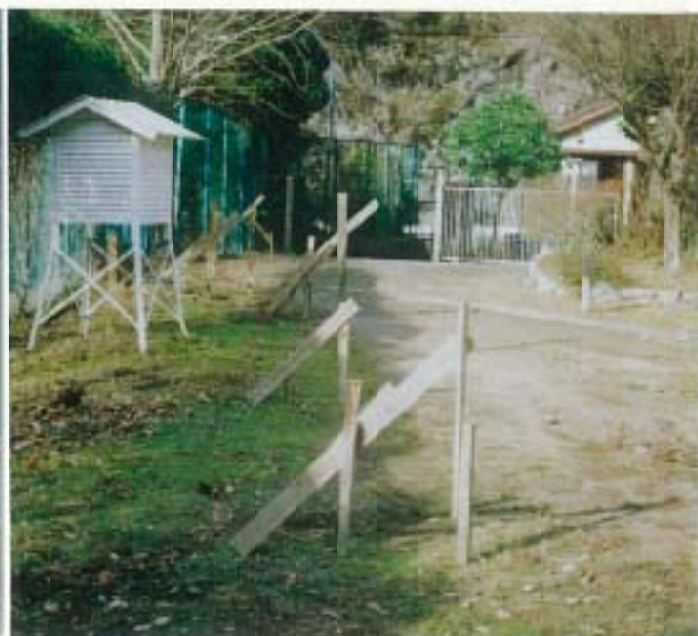
写真 2 校庭を掘り込む範囲の杭打ち
