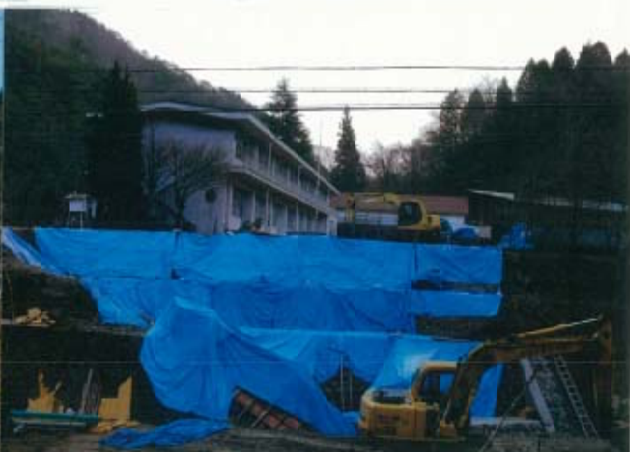
写真 4 工事中的様子
