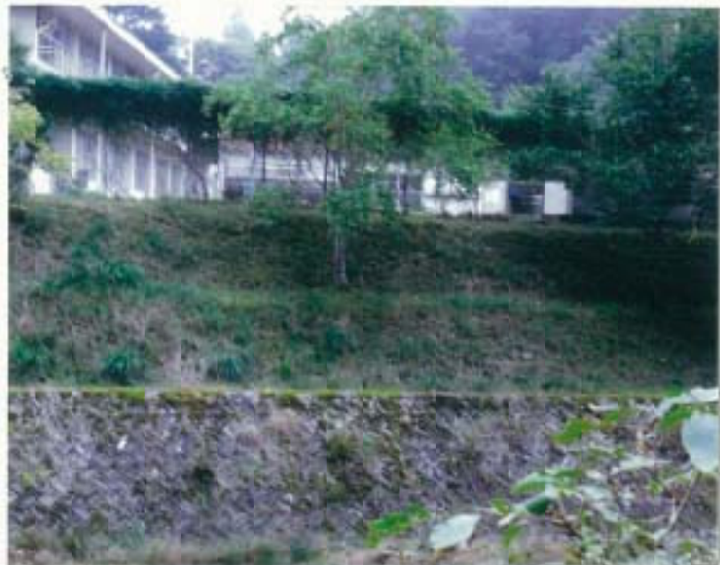
写真 1 校庭東側護岸の工事前
