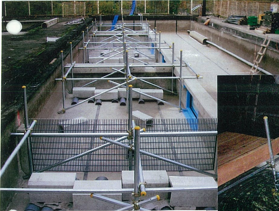
写真3 工事中のハンザキ収容プール
