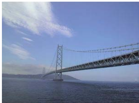
舞子公園から明石海峡大橋
