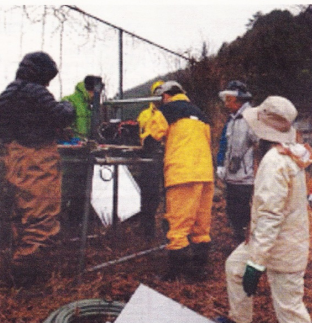
Installation d'un panneau solaire afin de pouvoir augmenter de quelques degrés une canalisation où les salamandres pondent leurs œufs.
