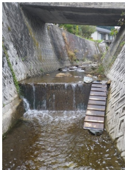
図1 扇形スロープ設置前の落差工（高さ約80cm） 仮設の木製スロープは県が設置
