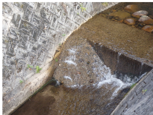
図2 スロープが設置後の落差工（図1と同じ箇所）
