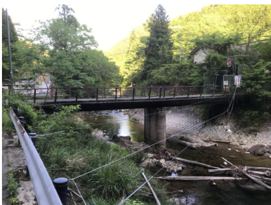
写真 1 平和橋 側面全景
