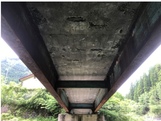
写真 5 平和橋 桁下面全景（国道側より）
