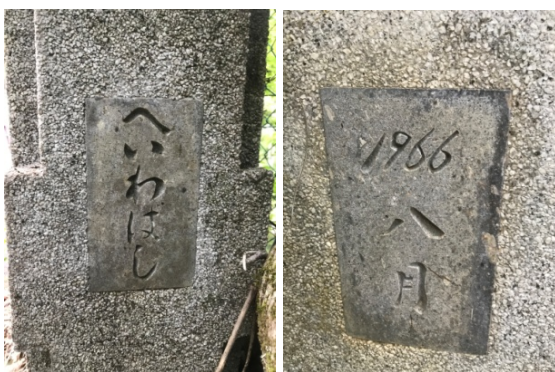
写真 2-3 橋梁名と竣工年を記したプレート
