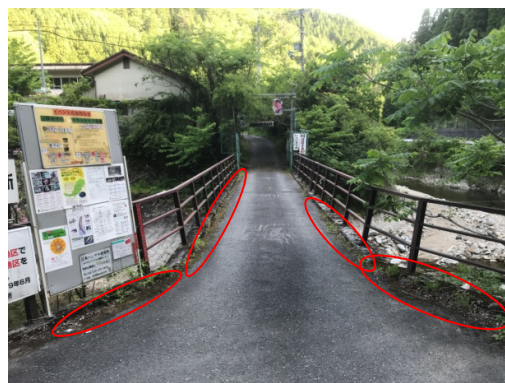
写真 4 平和橋 路面全景（国道側より）
