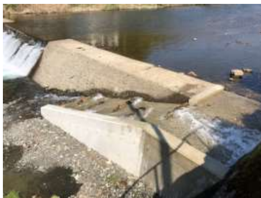
図 3 左岸に設置されたスロープ
